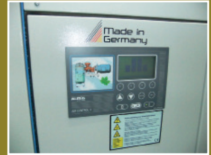
05 Die AirControl 3 schaltet die nachfolgenden Kompressoren abhängig von der prozentualen Auslastung des derzeitigen Grundlastkompressors optimal zu oder ab
