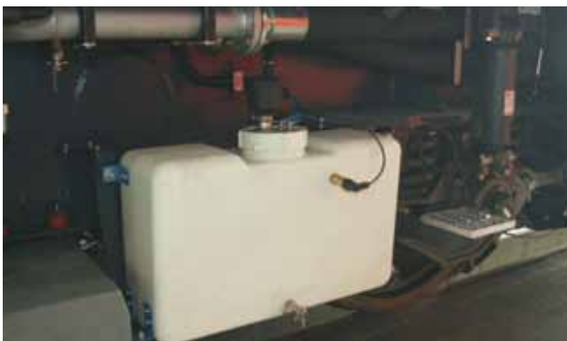
Abb. 2: Kondensatbehälter aus hochwertigem, flexiblem Kunststoff – geeignet auch für vereistes Kondensat
