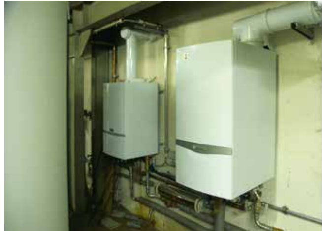
Bild 3. Zwei neue Gasthermen decken im Winter die Bedarfsspitzen ab
