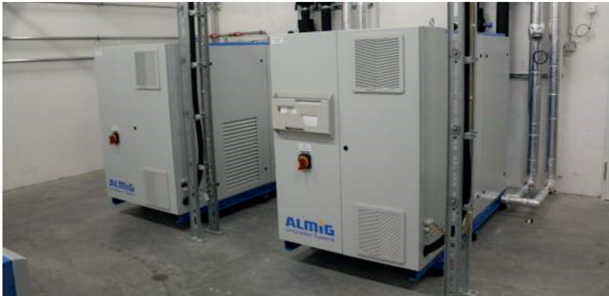
Losan Pharma setzt auf zwei direktgetriebene, drehzahlgeregelte Schraubenkompressoren der Type VARIABLE 55 von ALMiG.
