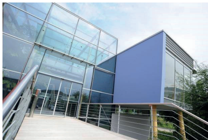
Kreative und zukunftsweisende Lösungen, das nötige technische Know-how und eine passgenaue Fertigung – die Moser GmbH ist auf Wachstumskurs. In der Produktion setzt der Hersteller auf Schraubenkompressoren von ALMiG.
