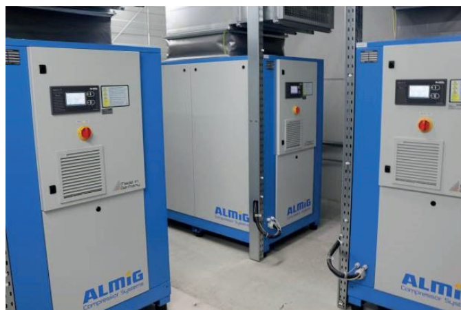
Die leistungsstarken Schraubenkompressoren der Baureihe V-Drive: Mit der Energiespar-Drehzahlregelung erreichen sie einen exzellenten Wirkungsgrad über den gesamten Drehzahlbereich.
