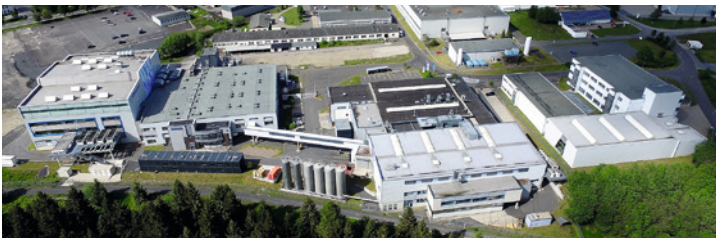
Röchling Medical in Neuhaus am Rennweg: Das Gebäude für die Reinräume wurde 2017 eingeweiht. Das Unternehmen musste seine Fertigungskapazitäten erweitern, um auf künftiges Wachstum vorbereitet zu sein. (Bildnachweis: Röchling Medical Solutions SE)
