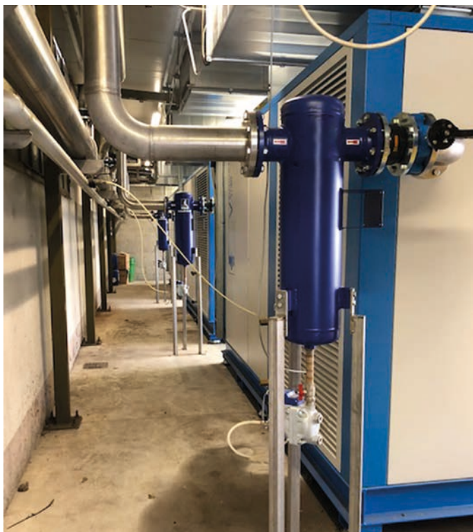
Im Einsatz sind nun drei neue hocheffiziente Schraubenkompressoren der Baureihe V-Drive T von ALMiG.
