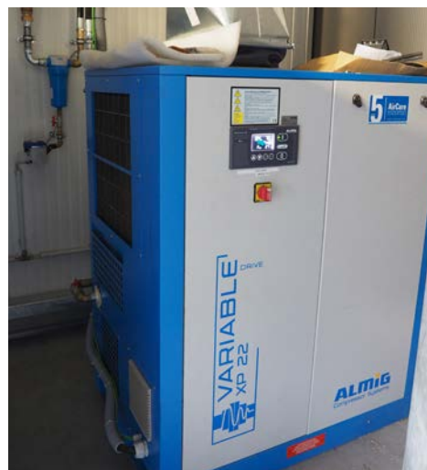
Der Variable XP ist in Schwachlastphasen im Einsatz – zum Beispiel nachts oder an den Wochenenden.
