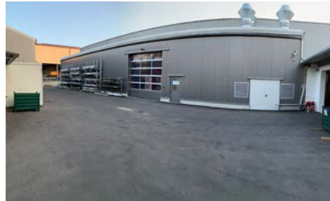
In der neuen Halle findet auch die neue Druckluftstation ihren Platz.
