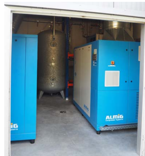
Mit dem neuen Druckluftbehälter steht nun ein Volumen von 3.000 Liter zur Verfügung.
